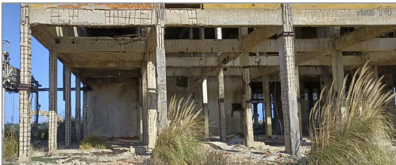
Vista 14 - Area ex TPF: Piano terra Fabbricato TPF (è evidente lo stato di estremo degrado della parti strutturali in cemento armato)
